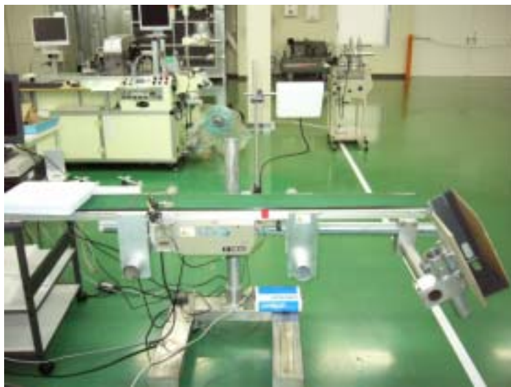
図 2-8 ベルトコンベア概観（アンテナ、センサを設置した状態）
