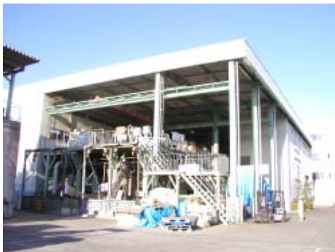
図 2-51 パイロットプラント全景（相川鉄工）
